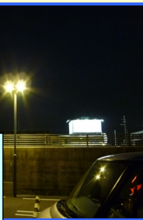
従来型駐車場照明 水銀灯500W ⇒LED駐車場照明 30W×2台
